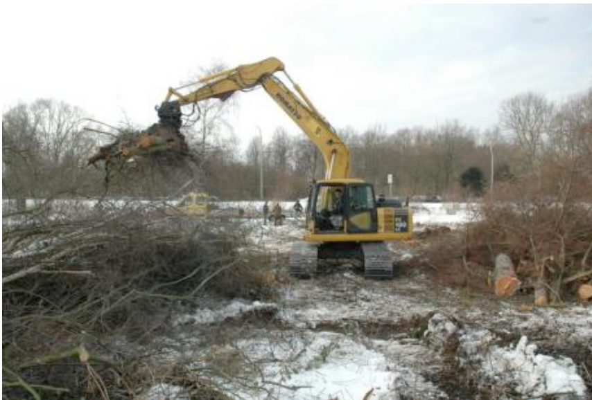
Baumfällarbeiten in Wilhelmsburg wegen der IGA Foto: Anima Berten
