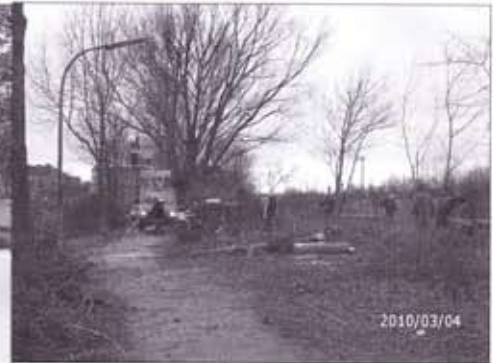
Fleißige Arbeiter an der Parallelstraße.
