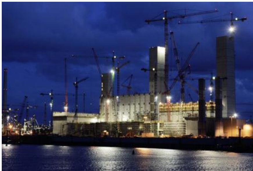
Die Baustelle des Kohlekraftwerks Moorburg im Juli 2009. Foto: dpa
